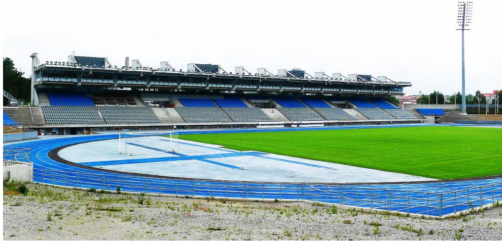
Kuva 2 Selostamotaso on ripustettu pääkatsomon ylle jännebetonirakentein
