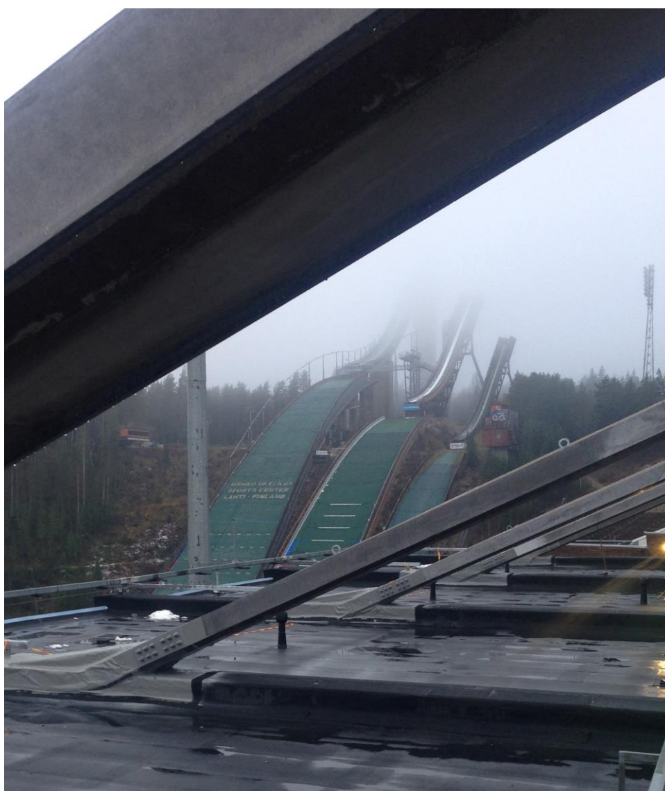
Kuva 4 Jännebetonisauvoja varmistavat teräsrakenteet asennettuina paikoilleen
